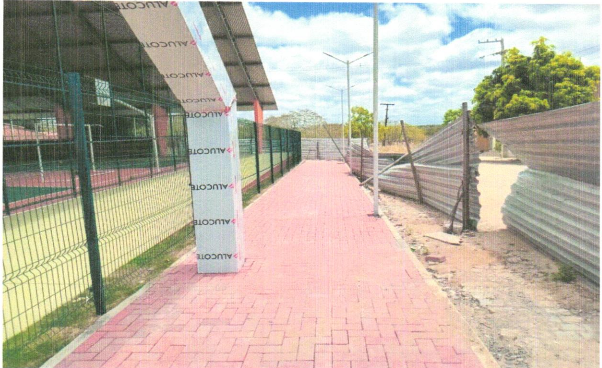
FOTO 36 - EXECUÇÃO DE PAVIMENTO EM PISO INTERTRAVADO, COM BLOCO SEXTAVADO DE 25 X 25 CM, ESPESSURA 6 CM. (LARANJA, AMARELO, GRAFITE, NATURA) AF_12/2015
