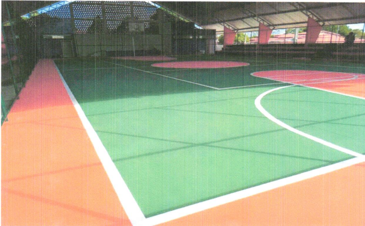
FOTO 82 - PINTURA P/PISO À BASE LATEX ACRÍLICO, TIPO "NOVACOR"
