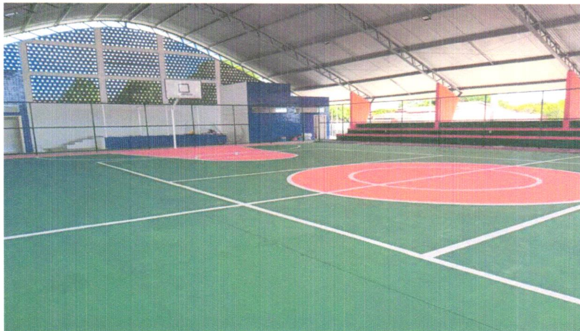
FOTO 80 - PINTURA ACRILICA DE FAIXAS DE DEMARCAÇÃO EM QUADRA POLIESPORTIVA, 5 CM DE LARGURA
