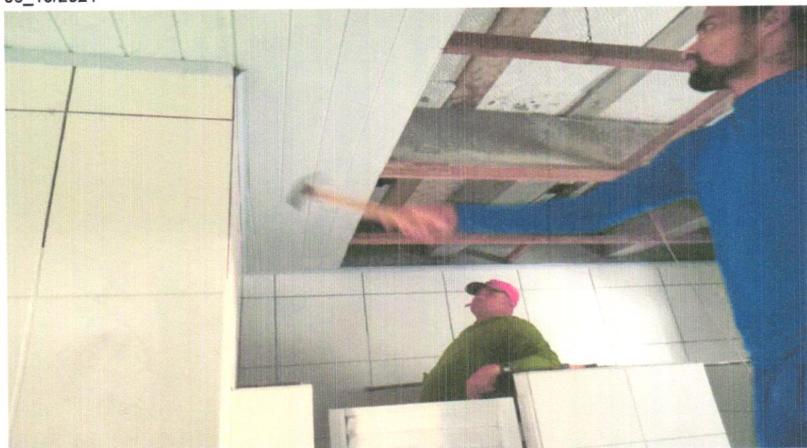
FOTO 22 - FORRO DE PVC, EM RÉGUAS DE 10 OU 20 CM, APLICADO, INCLUSIVE ESTRUTURA PARA FIXAÇÃO (PERFIS EM PVC) MARCA ARAFORROS OU SIMILAR, INSTALADO - REV 06_10/2021
