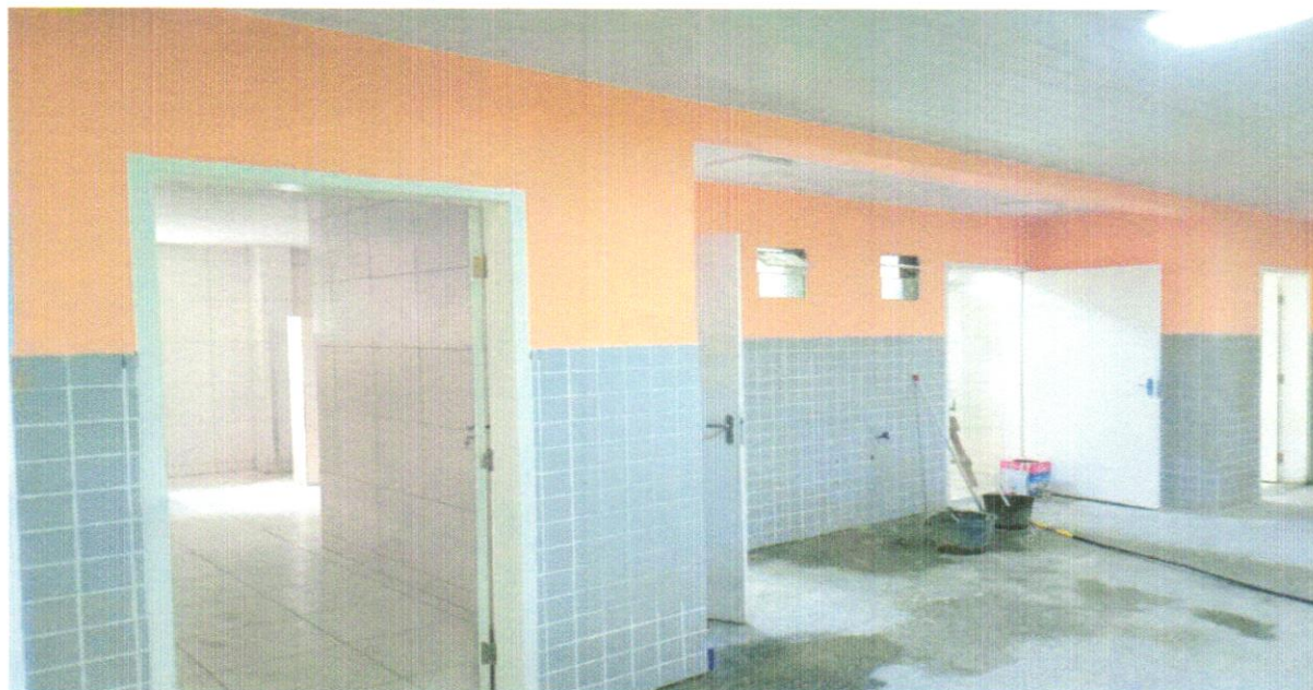
FOTO 38 - APLICAÇÃO MANUAL DE PINTURA COM TINTA LÁTEX ACRÍLICA EM PAREDES, DUAS DEMÃOS. AF_06/2014
