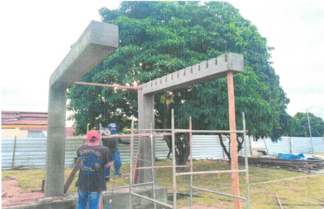
FOTO 60 - MADEIRAMENTO EM MASSARANDUBA/MADEIRA DE LEI, SERRADA 2,5CM X 10CM
