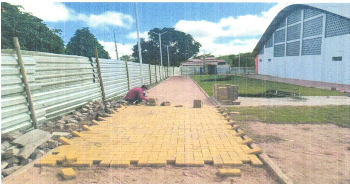
FOTO 34 - EXECUÇÃO DE PAVIMENTO EM PISO INTERTRAVADO, COM BLOCO SEXTAVADO DE 25 X 25 CM, ESPESSURA 6 CM. (LARANJA, AMARELO, GRAFITE, NATURA) AF_12/2015
