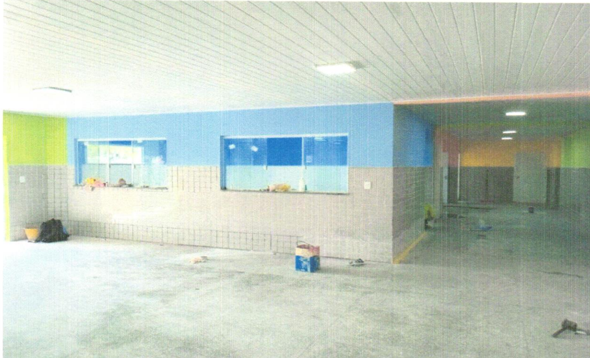
FOTO 38 - APLICAÇÃO MANUAL DE PINTURA COM TINTA LÁTEX ACRÍLICA EM PAREDES, DUAS DEMÃOS. AF_06/2014
