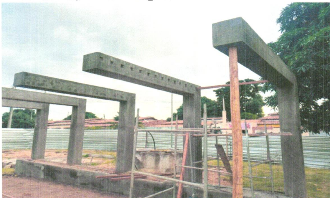
FOTO 58 - (COMPOSIÇÃO REPRESENTATIVA) EXECUÇÃO DE ESTRUTURAS DE CONCRETO ARMADO, PARA EDIFICAÇÃO HABITACIONAL UNIFAMILIAR TÉRREA (CASA EM EMPREENHIMENTOS), FCK = 25 MPA. AF_01/2017
