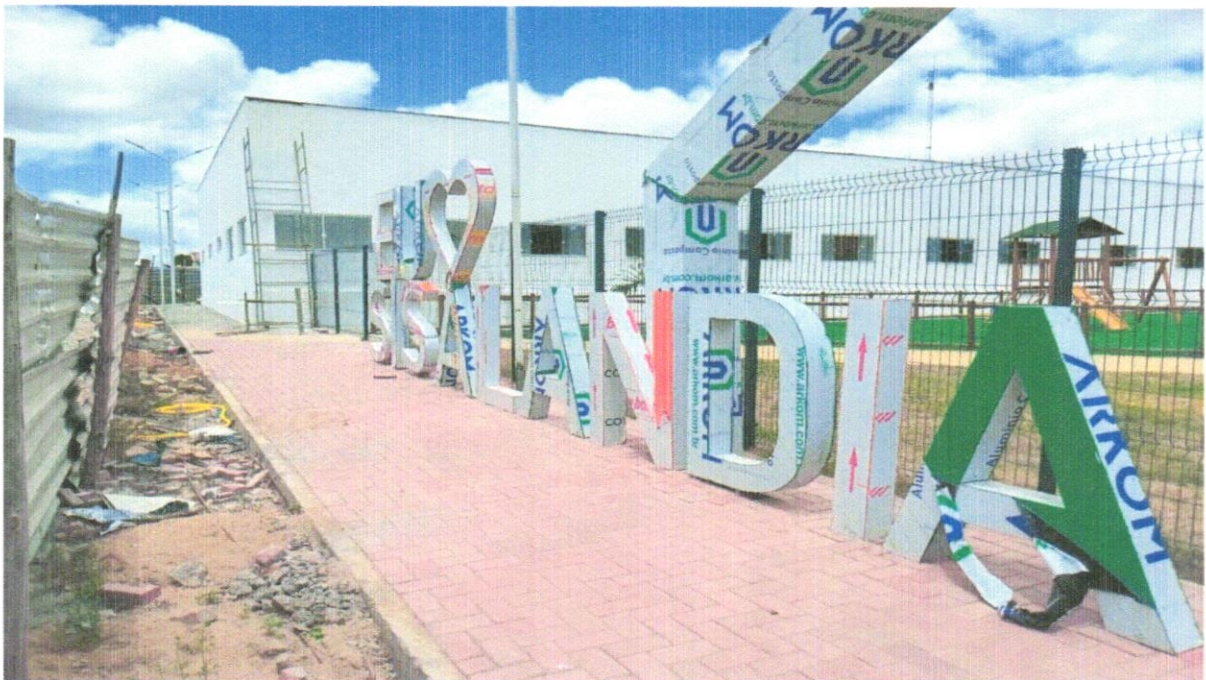
FOTO 92 - Revestimento metálico em alumínio composto (Alucobond), e=0,3mm, pintura Kaynar 500 composta por seis camadas, inclusive estrutura metálica auxiliar em perfil de viga "U" de 2" - fornecimento e montagem
